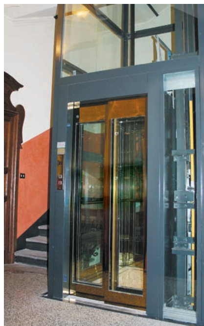
Εγκατάσταση Superdomus με μεταλλικό φρεάτιο σε κτίριο στο ιστορικό κέντρο της πόλης.
