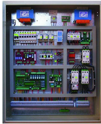
Υδραυλικός Πίνακας - Εκκίνηση Αστέρα - Τρίγωνο
